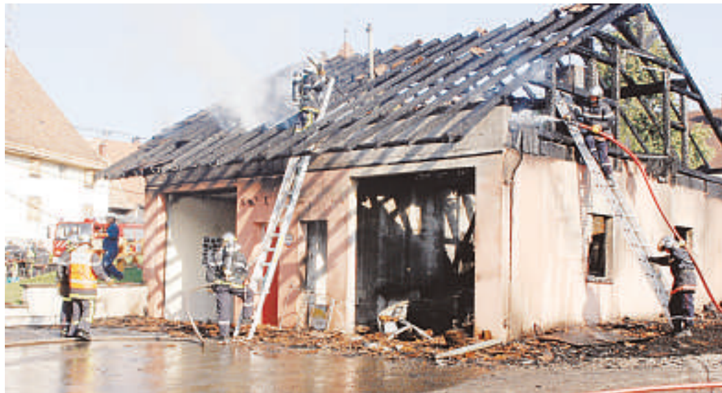
Le bâtiment abritait le dépôt incendie ainsi que le dépôt communal. C'est dans cette seconde partie que le feu a fait le plus de dégâts. (Photo DNA)
